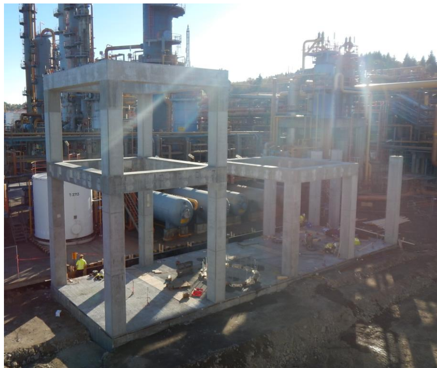
Betongstruktur HTDC ferdig – Oktober 2018
