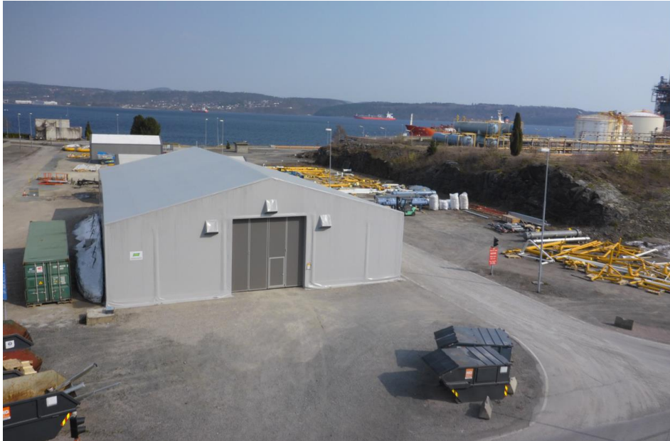
Lagertelt og midlertidige verksteder
